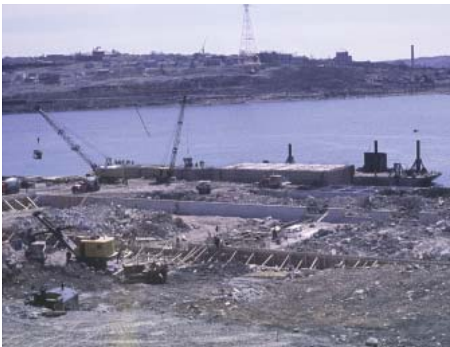
Travaux de construction sur le terrain de l'IOB en mai 1961 – photo de John Lazier.
