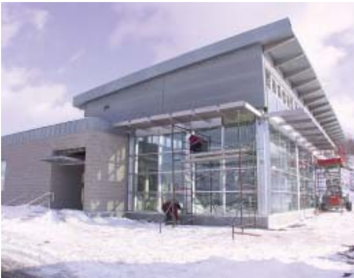
Le système de refroidissement sur la fin de son installation.
