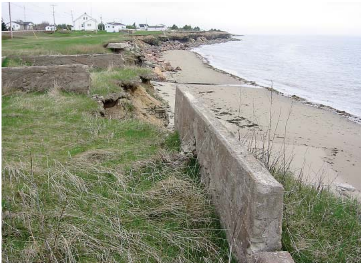
Des fondations abandonnées et partiellement effondrées attestent de l'érosion rapide des basses falaises à Cap-Lumière (N.-B.). Le long de cette côte, d'autres maisons et entreprises, y compris celles qu'on voit ici en arrière-plan, sont exposées à une érosion côtière accélérée par la montée du niveau de la mer et les effets du réchauffement climatique.
