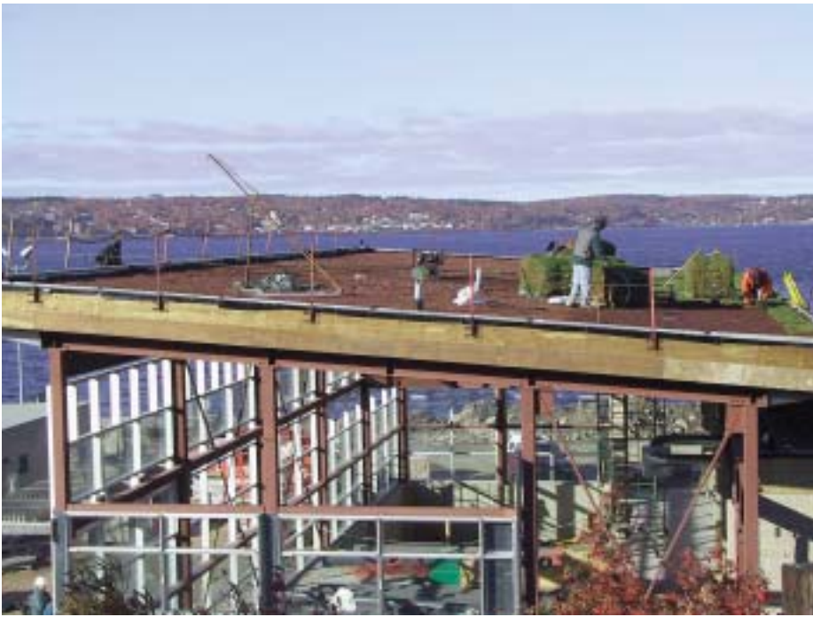
Pose du revêtement d'herbe de la toiture.
