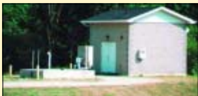
Poste de pompage d'eaux d'égout
