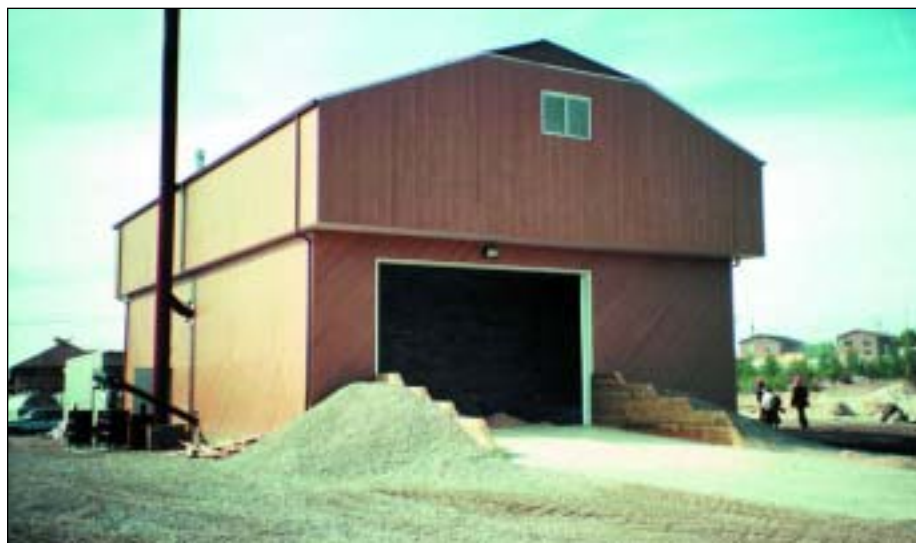
Installation de chauffage du district communautaire
