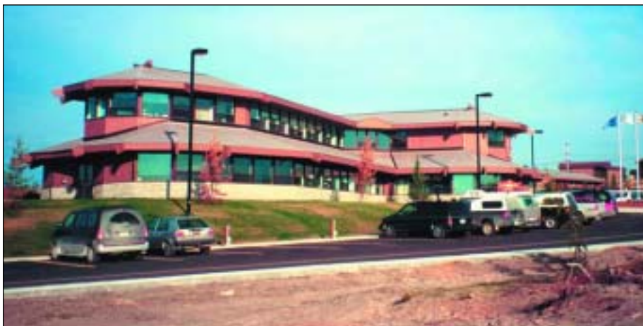
Immeuble de l'administration - éléments de conception culturels propres au style architectural des collectivités
