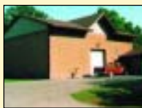
Station de traitement d'eau
