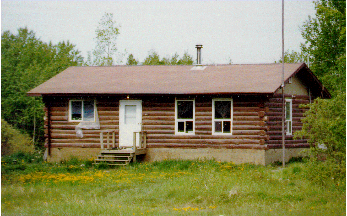
Figure 3 : On a construit à Sandy Lake cinq maisons avec des rondins usinés. Seul l'extérieur de la maison a l'apparence de rondins.
