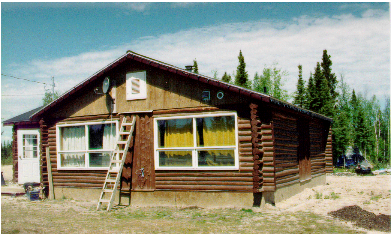
Figure 1 : Les quatre maisons de bois rond construites à Big Trout Lake présentent une combinaison de rondins verticaux et de rondins horizontaux.
