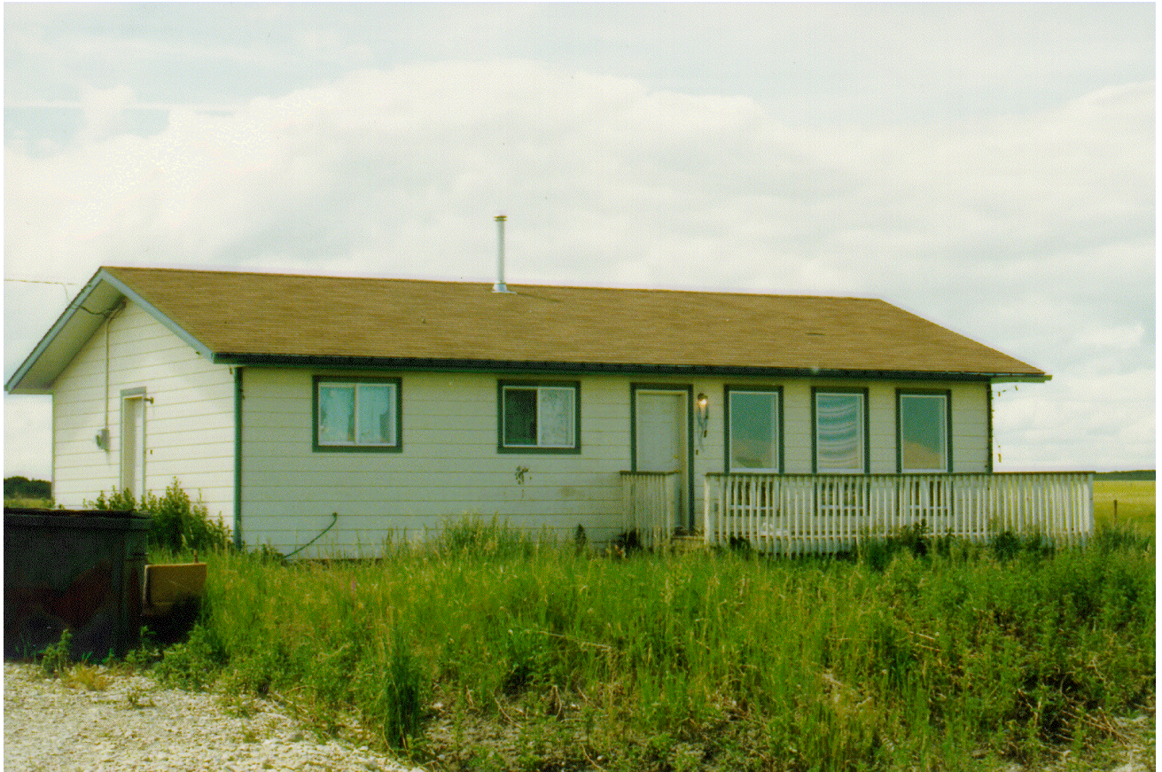
Figure 4 : Une des cinq maisons à ossature de colombages construite à Tsuu T'ina dans le cadre du projet-pilote.
