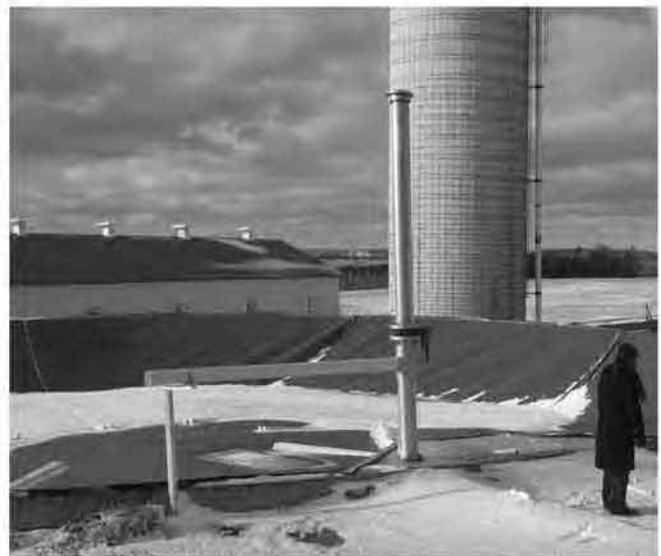
Fosse à fumier avec couverture à pression négative
