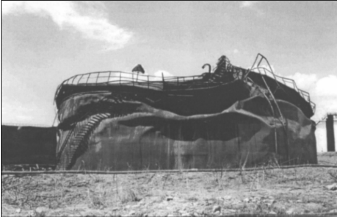
Figure 15 Dommages à un réservoir de stockage dans une raffinerie de pétrole lors du tremblement de terre de Kocaeli en Turquie (Saatcioglu et al. , 2001)
