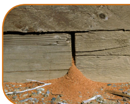
Accumulation de sciures expulsées d'un nid de fourmis charpentières Photo : Edward H. Holsten, USDA Forest Service, Bugwood.org
