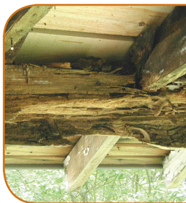
Domages causés par des fourmis charpentières dans le toit d'un porche Photos : Gerry Duprey
