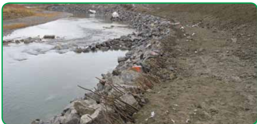
Ouvrage biotechnique de protection en roches avec couches de broussailles.
