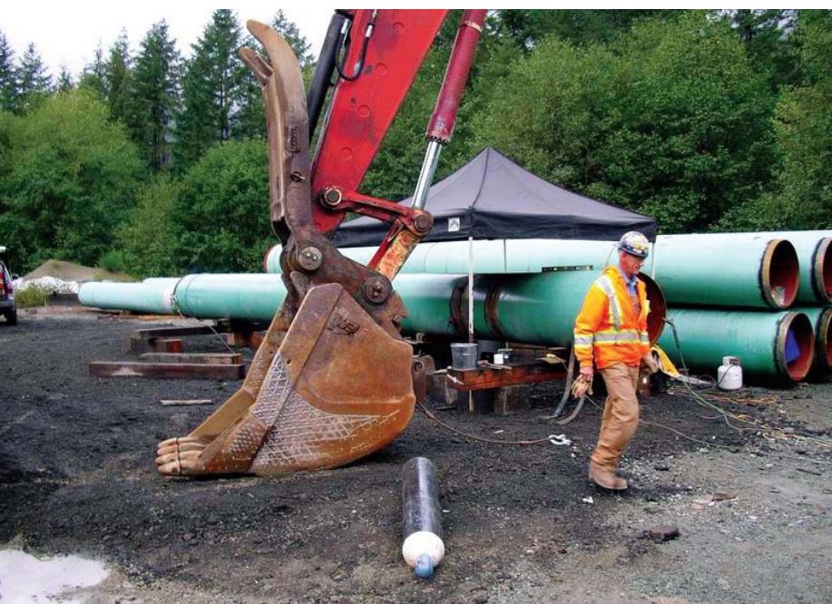
Construction de la centrale hydroélectrique de Canoe Creek Photo prise par : Daniel Van Vliet
