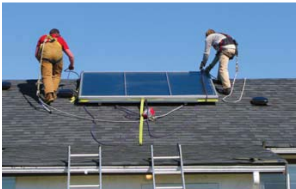
Installation de panneaux pour chauffe-eau solaire Photo prise par : Première nation des T'Sou-ke
