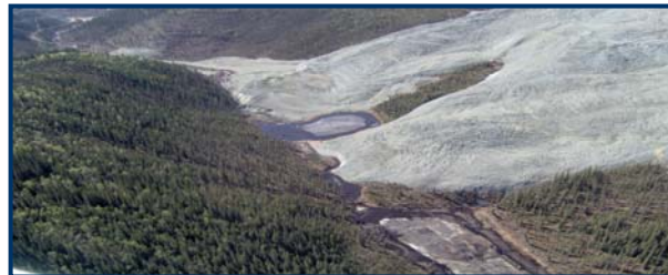
Stériles de la mine Clinton Creek
