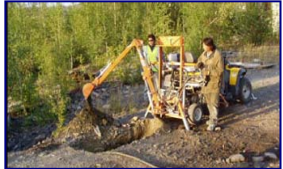
Excavation de sol contaminé à Discovery
