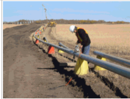
Image 6 : Inspection d'un pipeline END à l'aide d'équipement de gammagraphie industrielle
