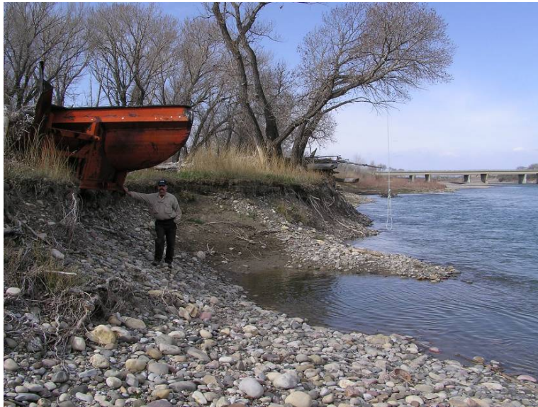
Figure 14. Rive sud de la rivière Oldman, juste à l'est du pont de la route 2 (visible à l'arrière-plan), à l'ouest de Fort MacLeod (face à l'ouest). Noter la grosse lame de chasse-neige coincée dans la berge. La superficie de sources et de zones de suintement pouvant convenir au S. bertae est si faible que ce genre de perturbation anthropique pourrait complètement détruire l'habitat. Photographie gracieusement fournie par Jennie Knopp.
