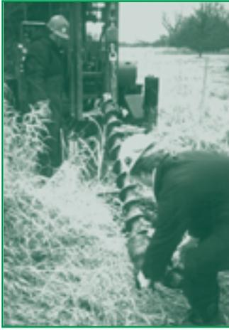
Installation d'un puits d'échantillonnage des eaux souterraines multiveaux dans le marais de la Pointe-Pelée.
