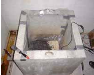
Installation d'une géomembrane TDR
