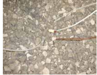
Installation des thermocouples et du capteur d'humidité
