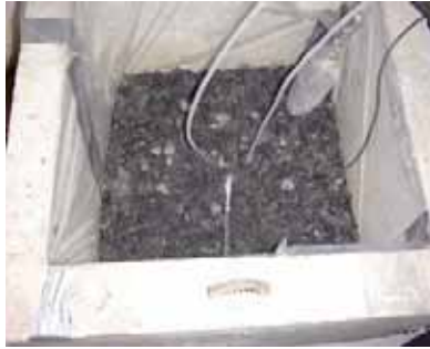
Installation des tubes à oxygène
