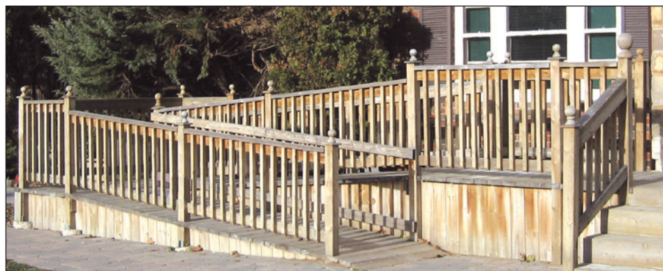
Figure 3 Rampe d'accès en zigzag
