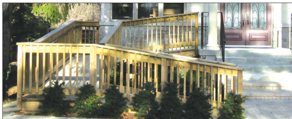
Figure 4 Rampe d'accès en U
