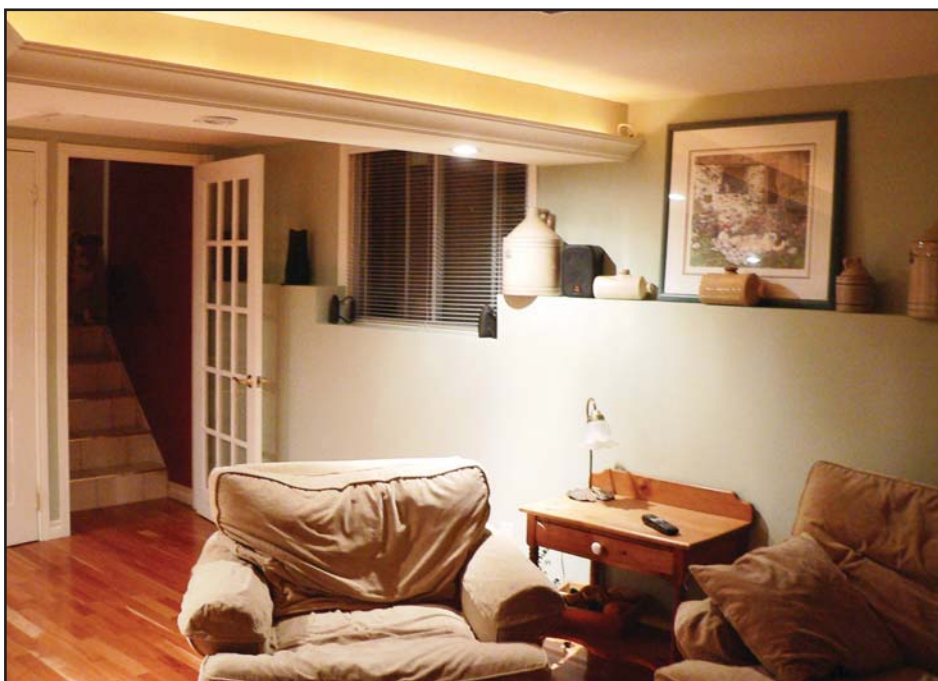
Figure 4 Grande fenêtre et retombée de plafond à 1 950 mm (6 pi 5 po) du sol
