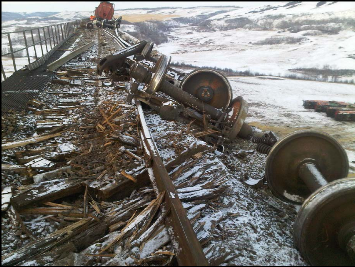
Photo 3. Extrémité est du pont
