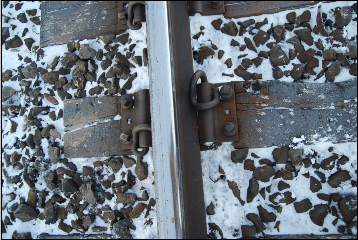
Photo 4. Système de fixation à selles laminées
