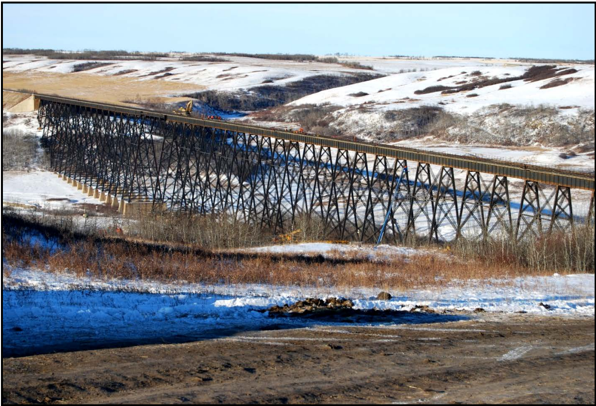
Photo 5. Pont de Fabyan, direction ouest
