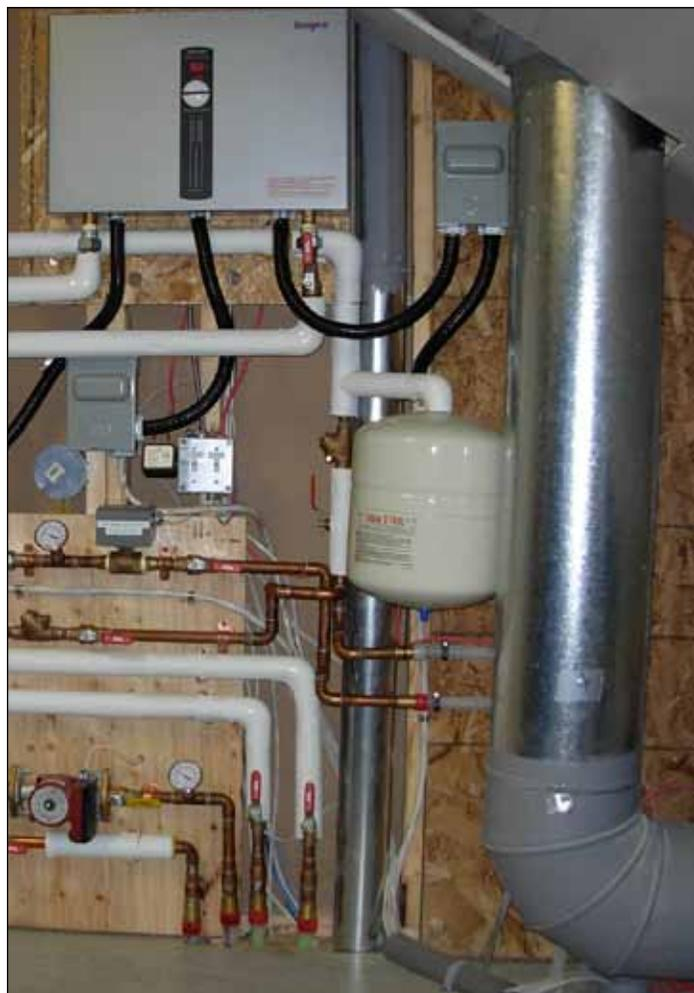
**Figure 1** Chauffe-eau sans réservoir installé dans la maison Avalon Discovery 3
