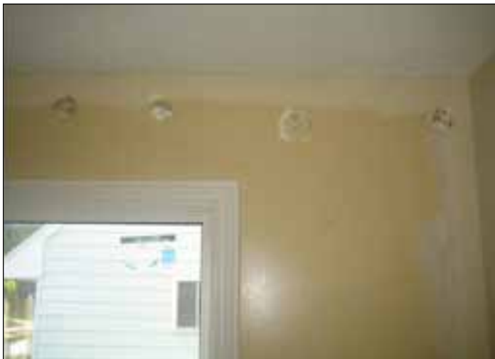
Figure 6 Trous percés pour appliquer la mousse de polyuréthane.
