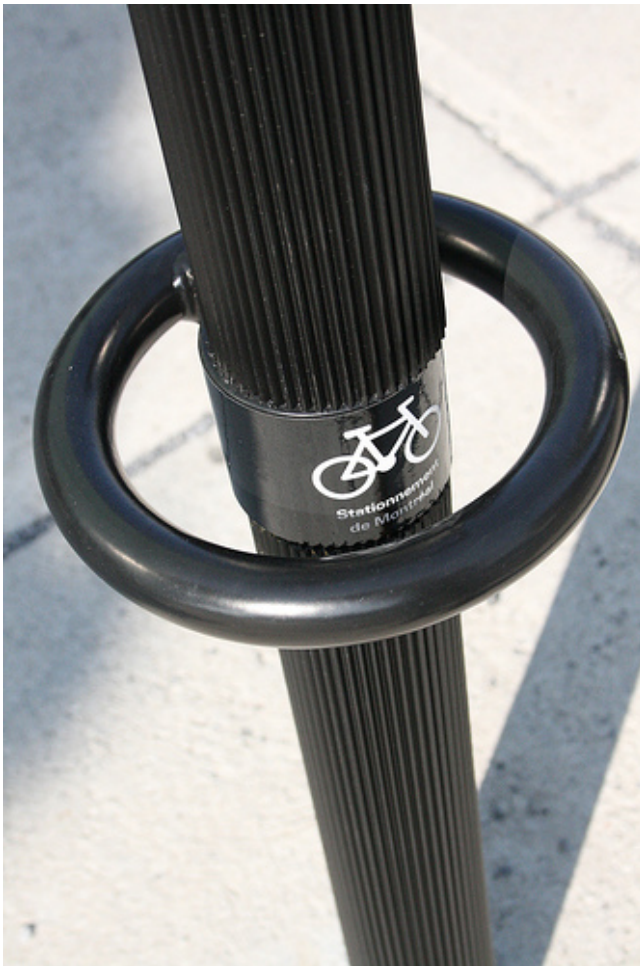
Figure 4 – Anneau de verrouillage des bicyclettes sur les parcomètres de Montréal (photo : Misha Warbanski)
