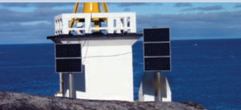
Les panneaux de cellules solaires constituent une source d'énergie durable de remplacement aux matières hautement radioactives qui alimentent les phares. Photo : Gouverneur du comté de Finnmark (Norvège)
