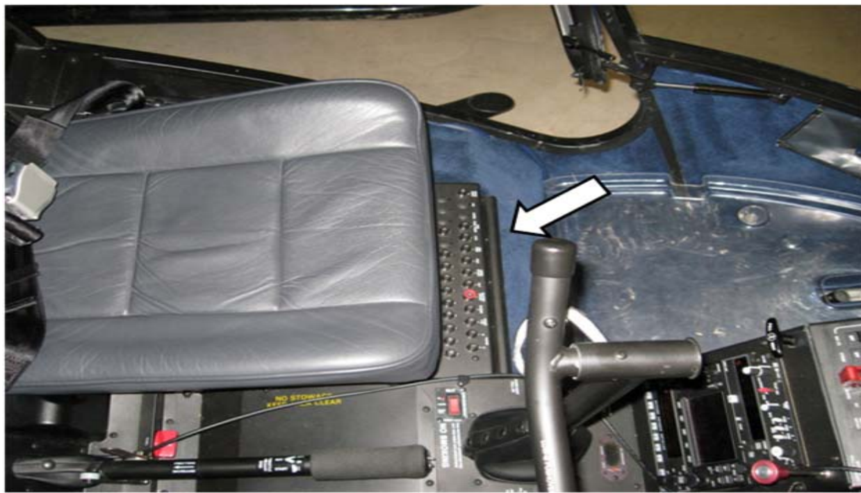
Photo 4. Panneau disjoncteur gauche
