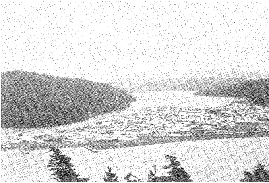
Fig. 3 La ville de Placentia (Terre-Neuve) est érigée sur une plaine basse de gravier qui était autrefois une crête de plage, et elle est déjà vulnérable aux inondations. Les plans de structures de protection côtière devront tenir compte des effets de la hausse prévue du niveau de la mer.
