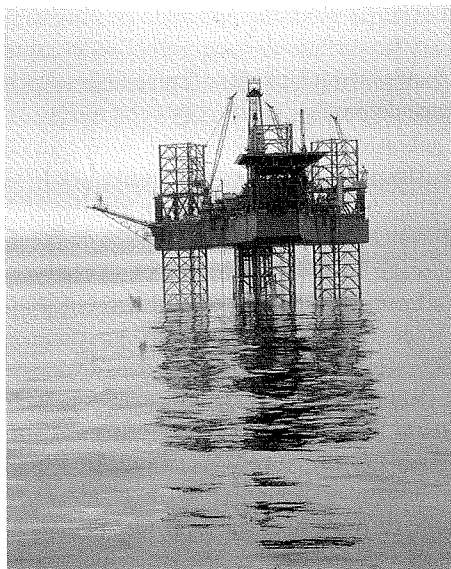
Plate-forme de forage extracôtier de Cohasset-Panuke
