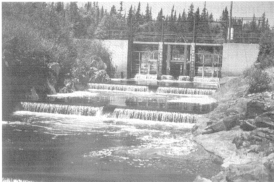
Figure 2: Pièges à poisson à l'extrémité supérieure de la passe migratoire de la rivière Liscomb.
