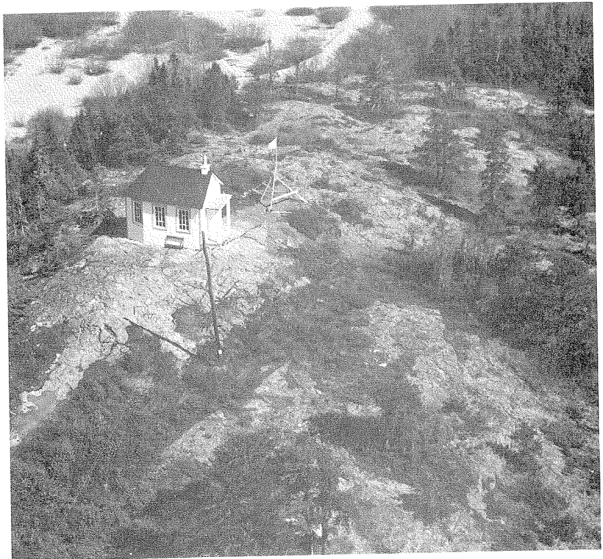
Station hydrographique sur la rive nord du golfe Saint-Laurent. (LOA 3998)
