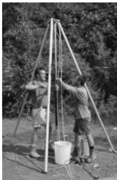
Installation des équipements requis pour la caractérisation du roc fracturé
