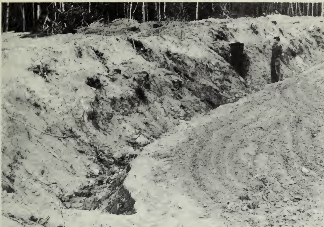
FIG. 5. Les débris de la tourbière sont poussés pour former une digue sur laquelle on aménagera une route d'accès. Le fossé qui sépare la tourbière de la digue sert à acheminer l'eau jusqu'à la vanne.
