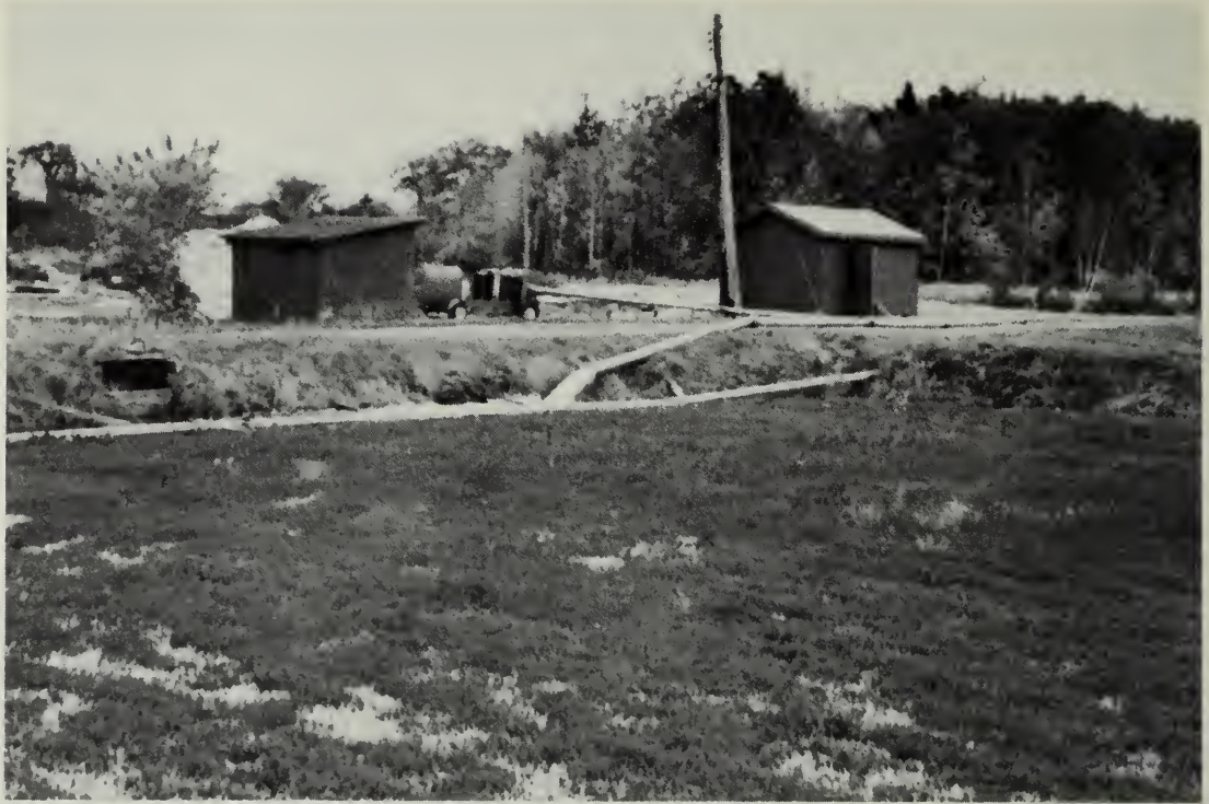
FIG. 4. L'eau joue un rôle important dans la production des canneberges. Le poste de pompage situé à droite abrite les pompes électriques qui assurent la circulation de l'eau dans le système d'irrigation par temps sec ou en période de gel. La pompe située à gauche est actionnée par un moteur à essence. Il s'agit d'un système d'appoint, au cas où il y aurait panne de courant. On l'utilise ici pour remplir d'eau la tourbière, avant la récolte.
