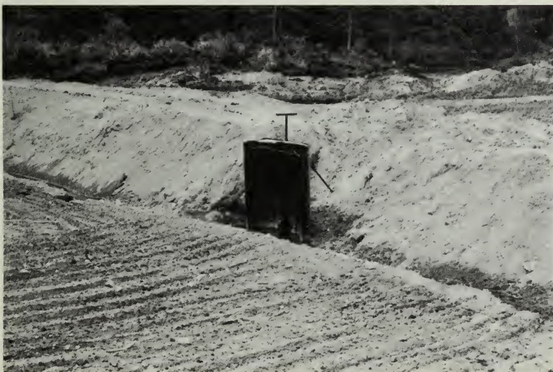
FIG. 6. Cette vanne est faite d'une moitié de réservoir à mazout. La valve, actionnée du dessus, permet de régler le niveau de l'eau pendant la récolte.
