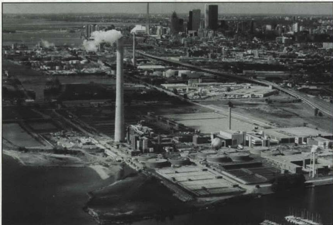
La station principale d'épuration des eaux usées du Grand Toronto
