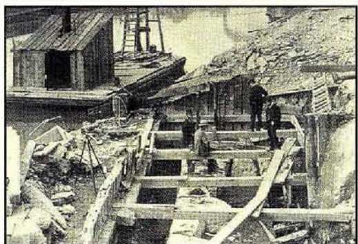
Le remblayage du marécage Ashbridge's
