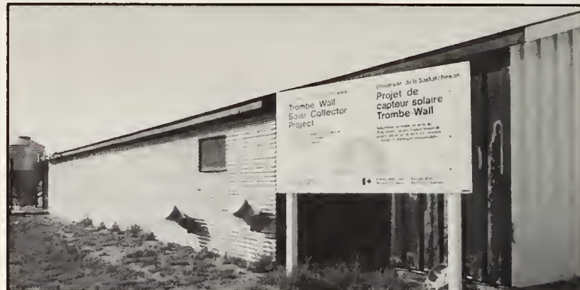
Fig. 8.2 Un capteur solaire pour le chauffage de l'air de ventilation d'une porcherie.
