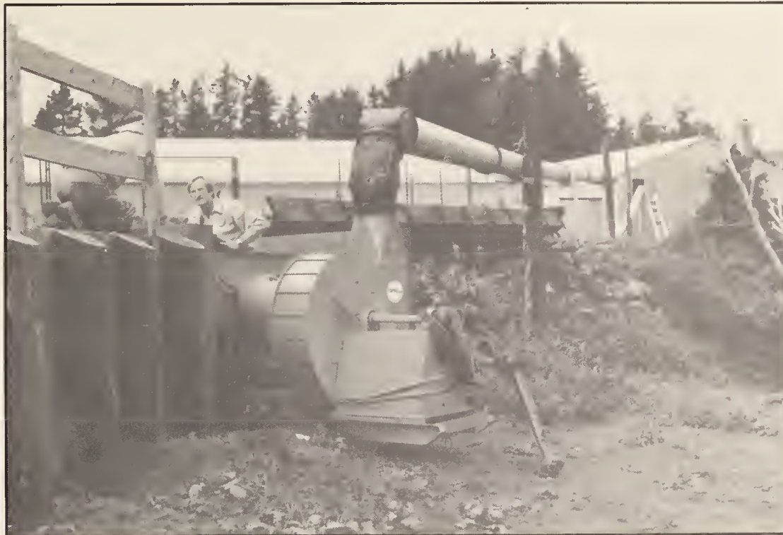
Fig. 8.10 Un gazéificateur de bois pour le chauffage à la ferme
