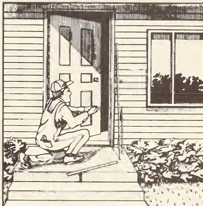
Fig. 3.3 L'installation de coupes-bise permet de réduire les pertes de chaleur autour des portes et des fenêtres (référence no 2)
