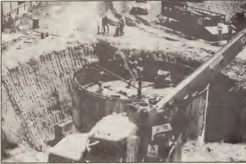
Fig. 8.13 Construction d'un digesteur anaérobie
