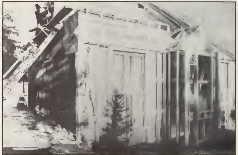
Fig. 3.15 Coupe-vapeur, murs et toit nouveaux
