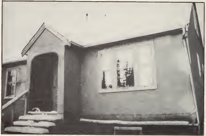
Fig. 3.14 Maison avant la rénovation
