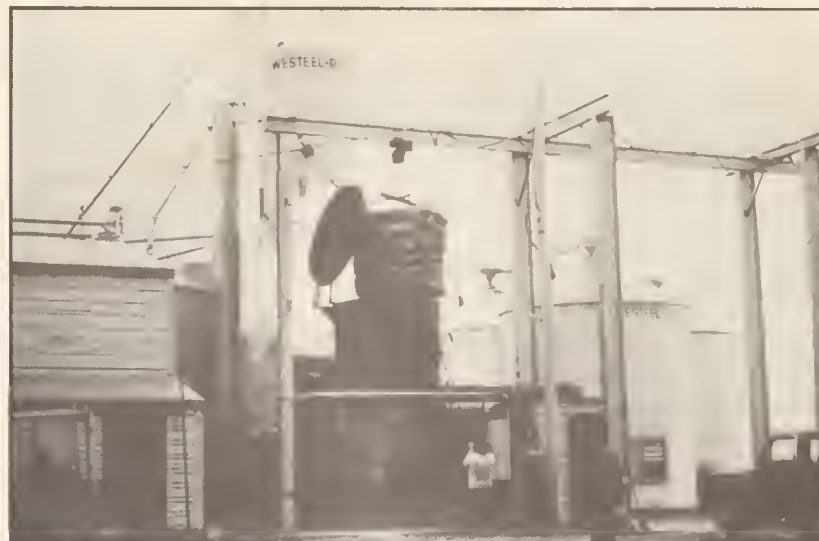
Fig. 8.1 Agriculture Canada a commandité plusieurs projets énergétiques à l'échelle de la ferme. Nous apercevons ici une chaudière à paille faisant l'objet d'essais en Nouvelle-Écosse (voir la section 8.5)
