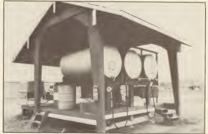
Fig. 2.12 b) Les pertes par évaporation sont réduites lorsque les réservoirs sont de couleur pâle, protégés contre le soleil et munis de soupapes de sûreté.
