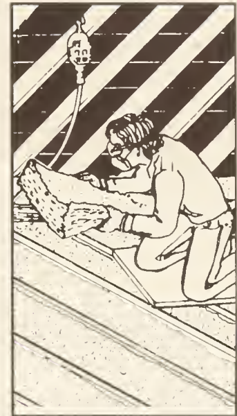
Fig. 3.7 Installation d'isolant en natte dans un grenier non chauffé
