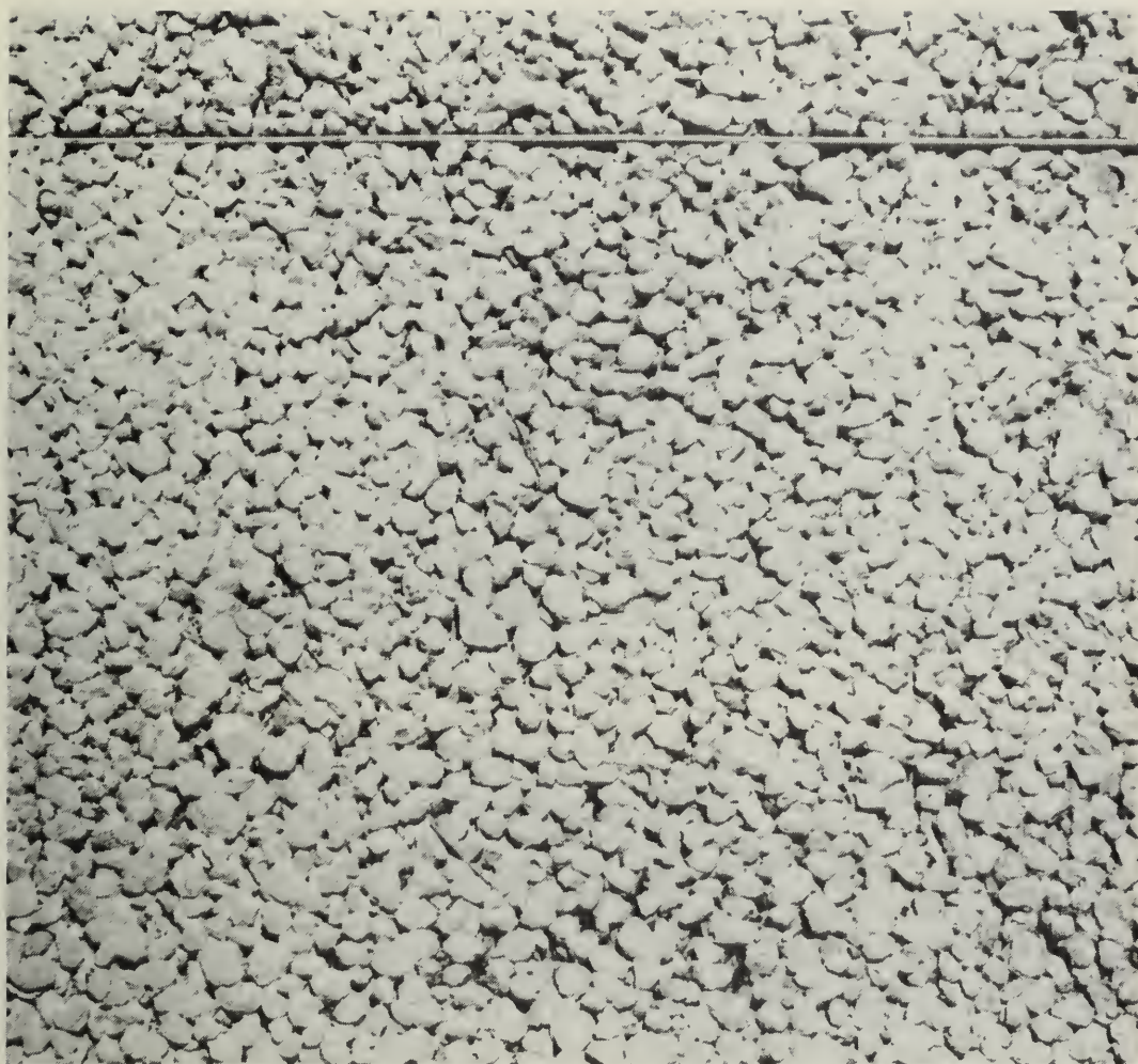
Fig. 5 Plancher en béton mousse permettant à l'eau de s'égoutter.
