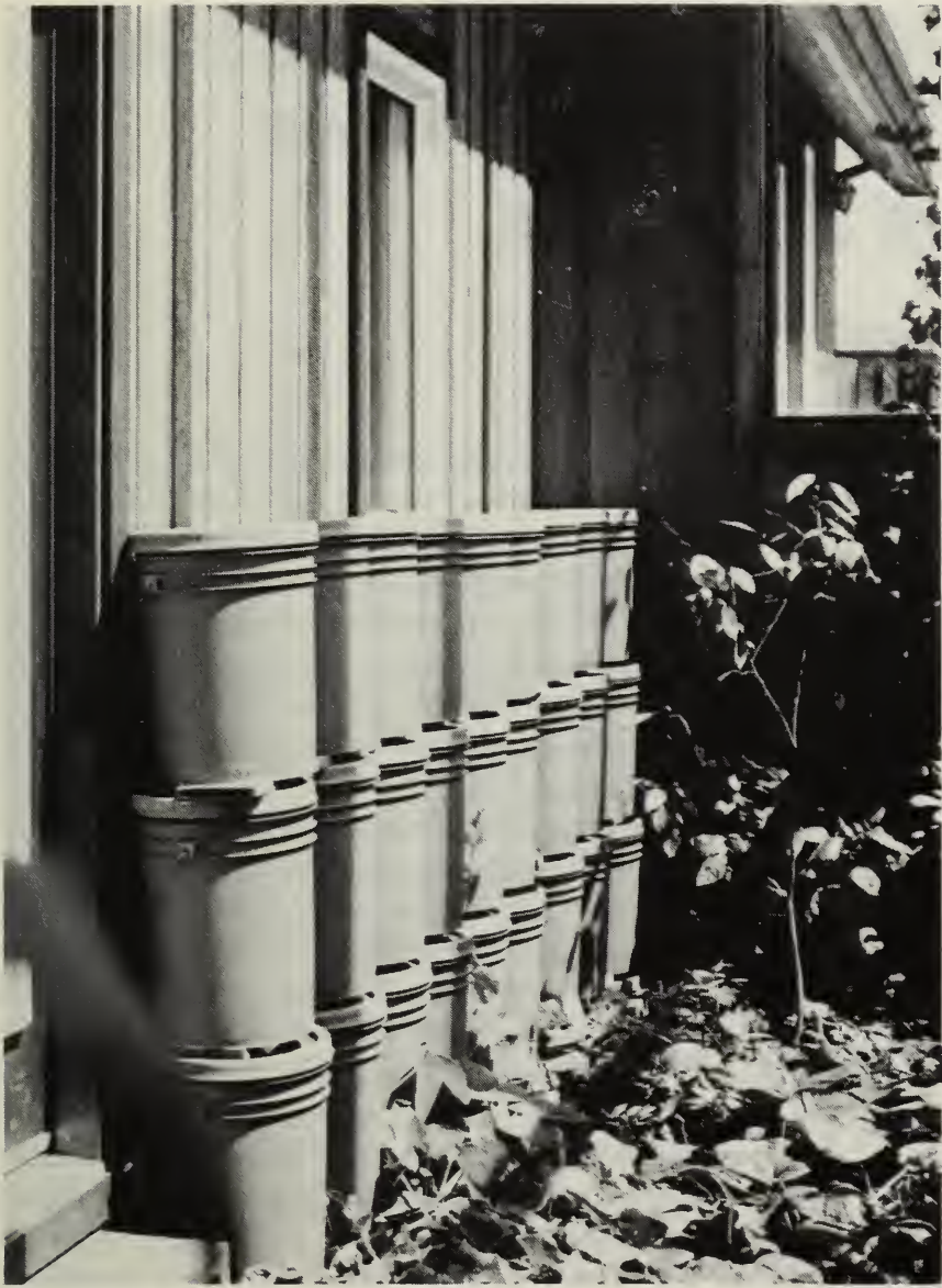
Fig. 17 Bidons d'eau servant de stockage thermique dans une petite serre.
