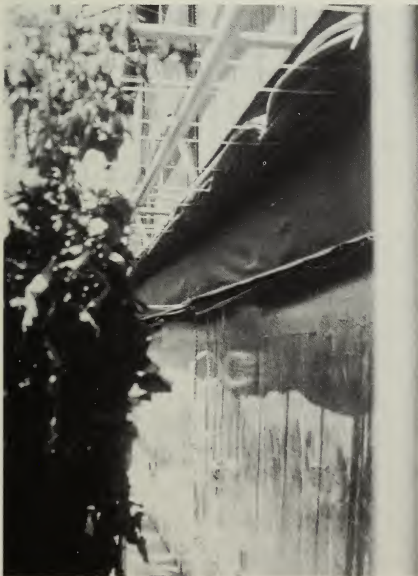
Fig. 12 Mur nord isolé dans une demi-serre. Les capteurs solaires, qui sont suspendus à un dispositif d'enroulement, sont ici enroulés pour réfléchir la lumière.
