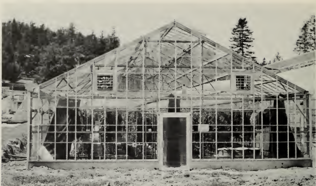
Fig. 6 Serre individuelle avec ouvrant latéral ouvert en premier, suivi de l'ouvrant en toiture situé sous le vent.
