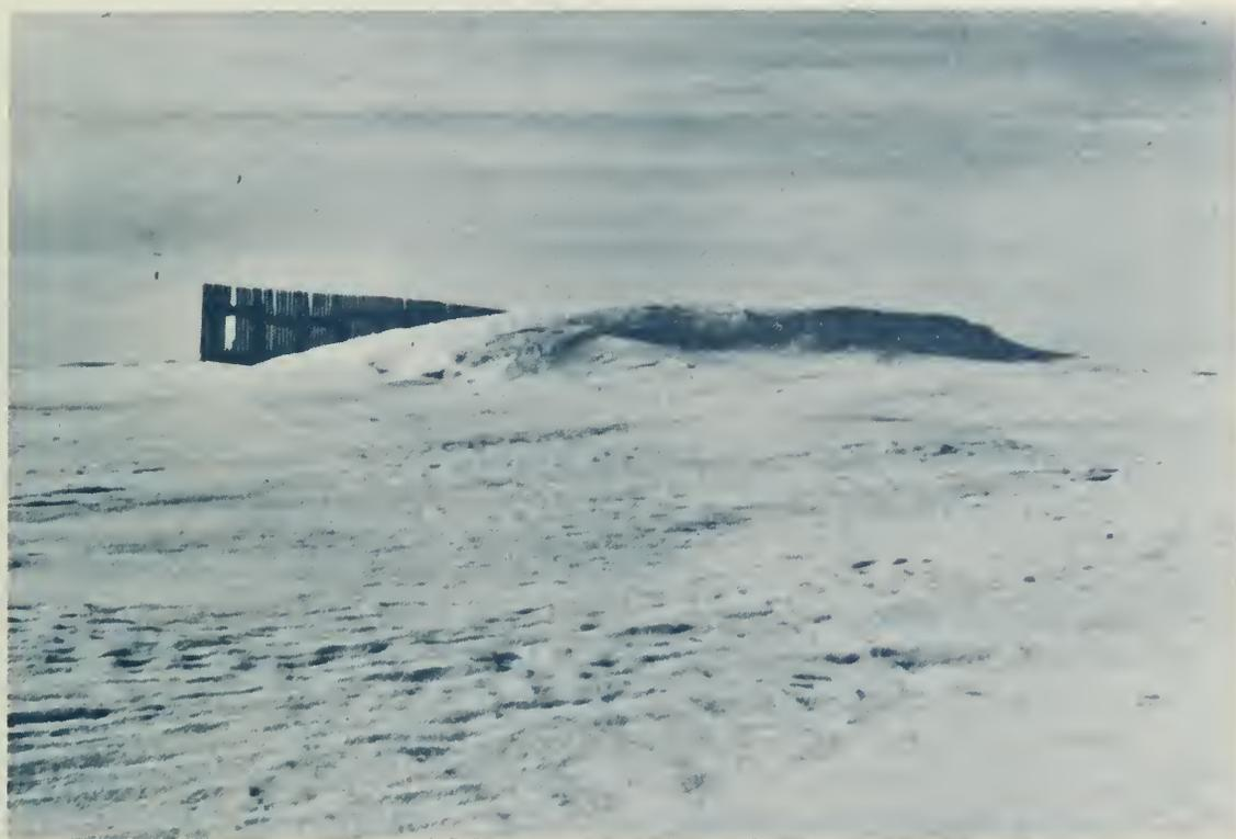
Figure 5. Les amas se forment du côté sous le vent d'une palissade à claire-voie. Celle-ci, d'une densité de 70%, crée une congère sur une distance assez grande.
