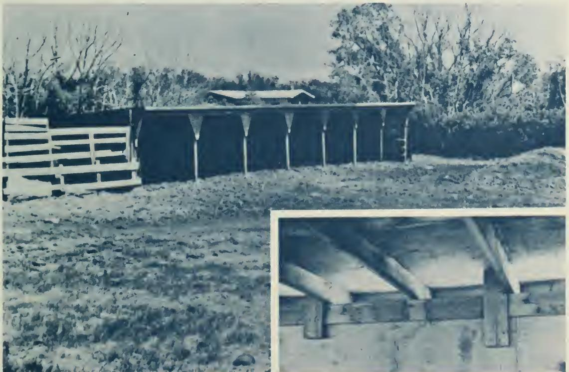
Figure 8. Abri à façade ouverte. L'image en médaillon montre la petite ouverture sous les gouttières. A remarquer, la méthode simple employée pour fixer les chevrons à la poutre principale.
