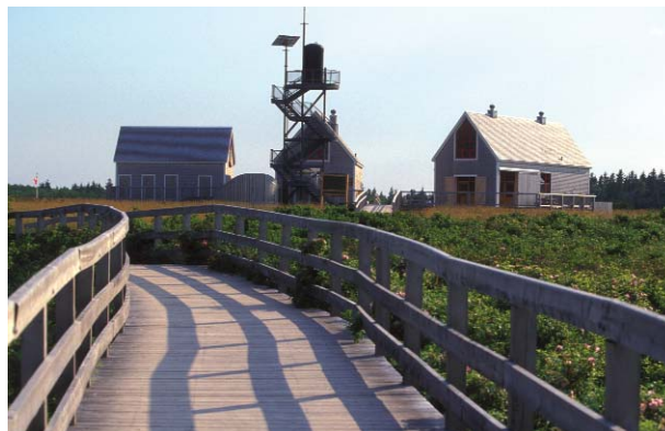
Sentier des dunes de Greenwich et centre d'accueil des visiteurs, parc national du Canada de l'Île-du-Prince-Édouard © Parcs Canada Photo : J. Sylvester
