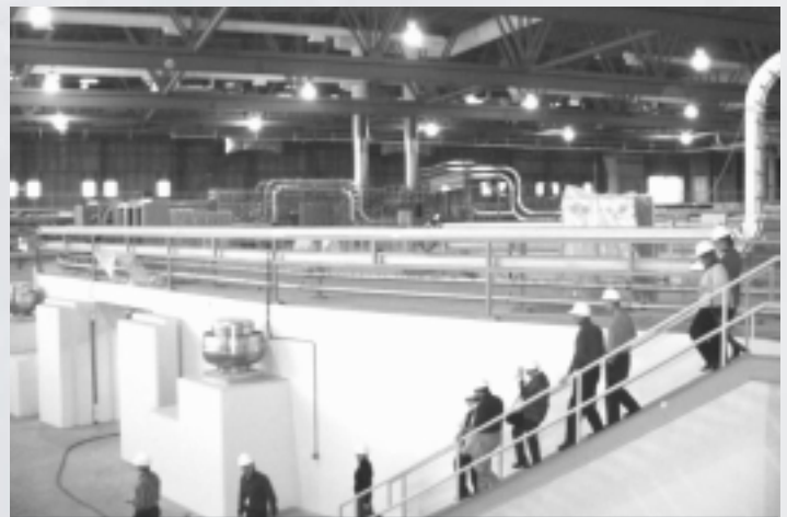
Descente au niveau du sol en suivant le mur extérieur de l'anneau d'accélération. De cet anneau, le rayon est transféré dans l'anneau d'entreposage où les électrons sont amassés. L'accélération radiale du rayon à travers les aimants de l'anneau d'entreposage produit la lumière synchrotron.
