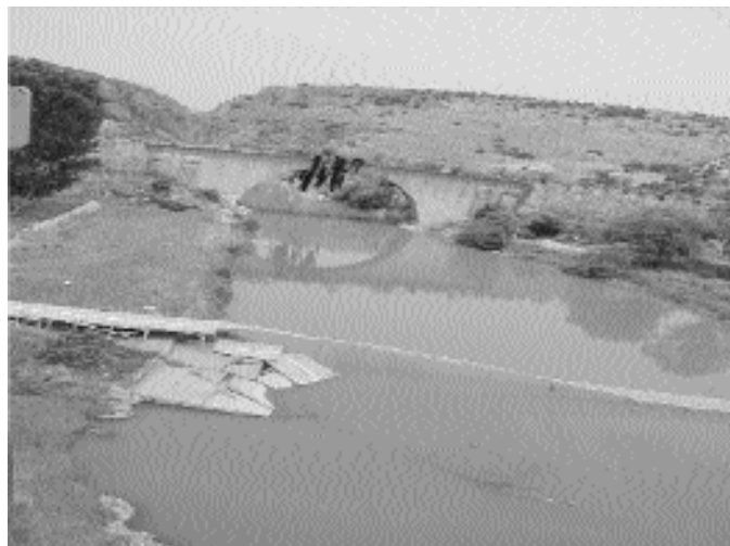
Figure 1. Grandes bandes de tissu noir déposées sur un pont pour tromper les ressources de surveillance aéroportées et pont factice pour leurrer les systèmes de ciblage. (Emplacement : Itinéraire Duck, Kosovo)
