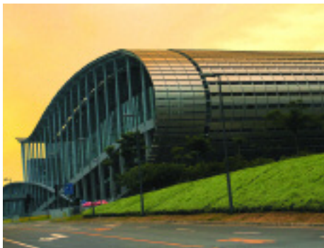
Centre des expositions de Guangzhou.
