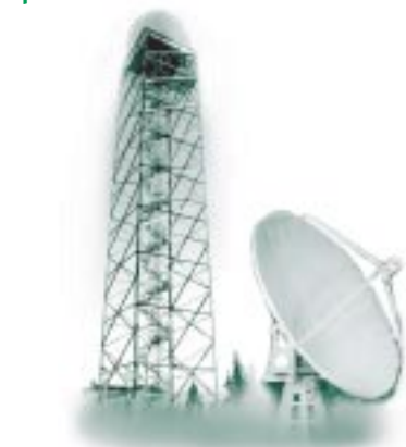
Tour du radar Doppler à Spirit River, en Alberta; système d'antenne du radar Doppler (fabriqué par Andrew Canada)
