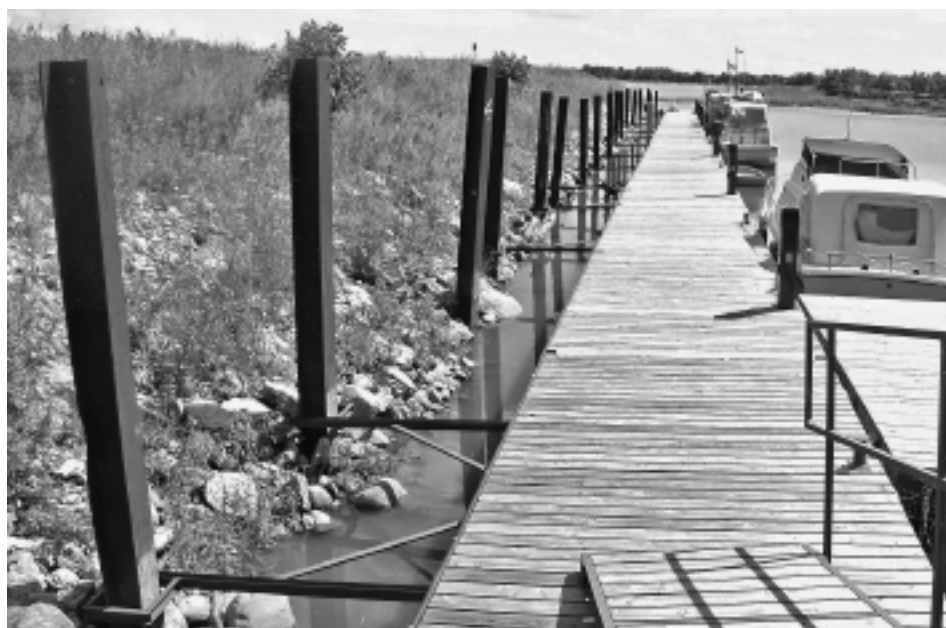
À Winnipeg Beach, des nouveaux quais flottants remplacent un quai sur pieux de bois vieux de 50 ans. Les quais flottants, fabriqués en Douglas taxifolié et comportant des réservoirs remplis de mousse polystyrène, sont ancrés à la rive au moyen de pieux d'acier. Le système d'ancrage permet aux quais de monter et descendre selon les variations du niveau d'eau.
