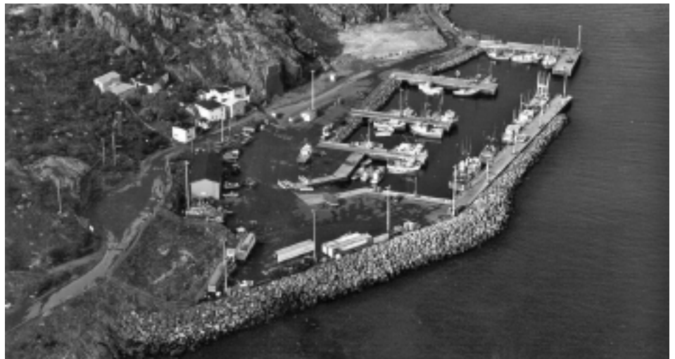
Le Fort Amherst Small Boat Basin, comprenant une grande zone asphaltée pour les camions (qu'on peut voir à la gauche de la photo), l'espace pour les bureaux de l'Administration portuaire et les ateliers, les brise-lames et les quais, a été aménagé sur la rive rocheuse et escarpée du « goulet », le canal qui mène au Port de St. John's.
