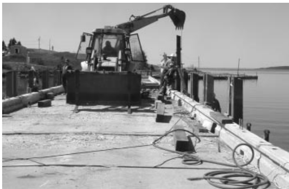
On répare et restaure un quai en ajoutant de nouveaux éléments de bois au caisson actuel et une nouvelle plate-forme en béton, dans le cadre du projet de développement du port de Petit-de-Grat au Cap-Breton, en Nouvelle-Écosse.
