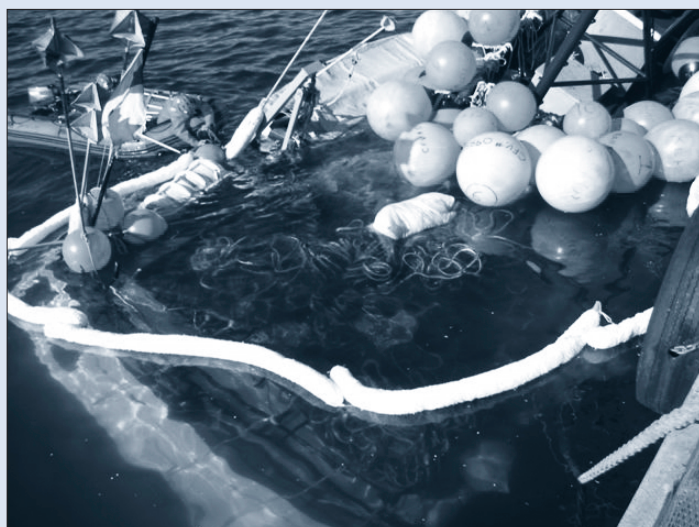
DÉPLOIEMENT DU BARRAGE DE CONFINEMENT AUTOUR DE L'EXCAVATRICE
