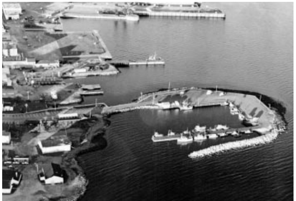
Réfection complétée du port de North Sydney Ballast Grounds (à l'avant-plan).
