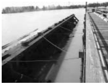
Un pare-débris à Mission (Colombie-Britannique) protège le quai contre les débris flottants. Remarquez les barrières de béton et les câbles qui fixent le quai.
