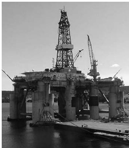
La Glomar Grand Banks domine le port de Bay Bulls mais, grâce à la planification et à la coopération entre tous les intervenants, n'endommage pas les lieux de naufrage historiques qui s'y trouvent.
