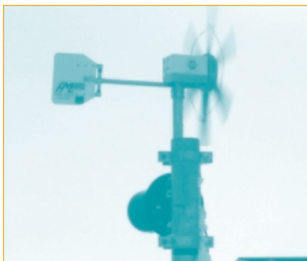
▲ Ce relais radioélectrique éloigné, situé à Kananaskis (Alberta), utilise l'énergie éolienne et l'énergie solaire pour produire de l'électricité. (Photographie offerte gracieusement par Nor'wester Energy Systems Ltd.)
