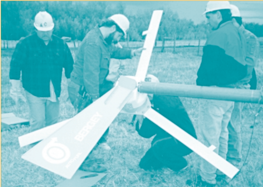
▲ Étudiants du Collège Assiniboine (Manitoba) installent une éolienne de 850 watts. (Photographie offerte gracieusement par Nor'wester Energy Systems Ltd.)
