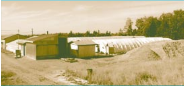
Les serres et le séchoir de Denco Enterprises. Le biocombustible est stocké à la droite.
