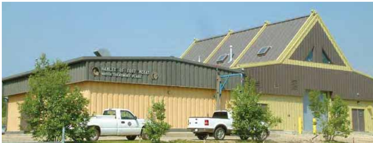
CI-DESSUS : Usine de traitement d'eau de la Première nation de Fort McKay
