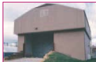
Bâtiment de la chaudière à bois
