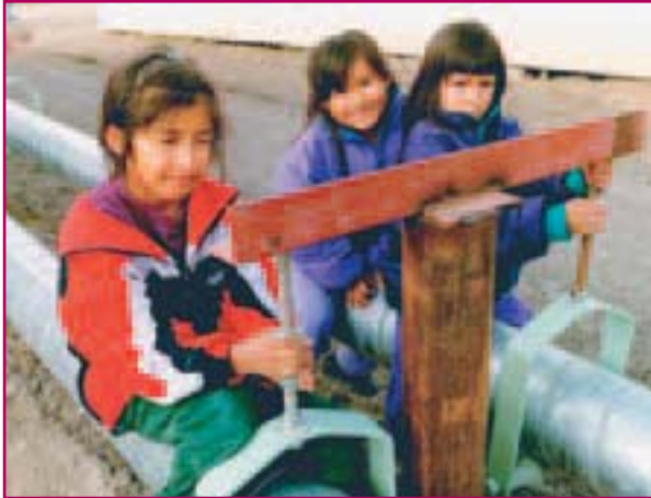
Tuyaux en surface
