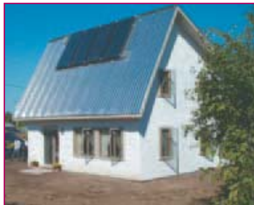
La maison saine de Kanata avec panneaux solaires installés
