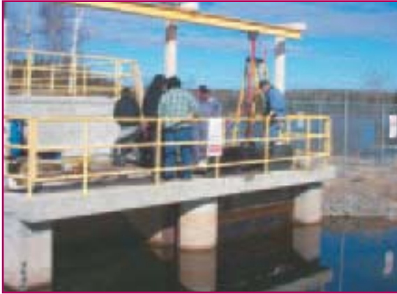
Réparation et entretien de la centrale hydroélectrique
