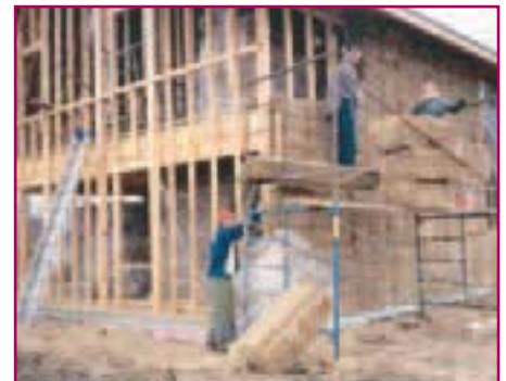
Construction de la maison saine de Kanata
