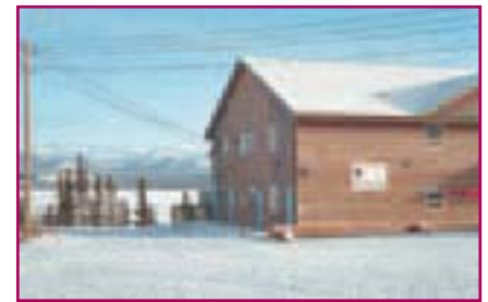
Bâtiment de l'administration de la Première nation de Kluane
