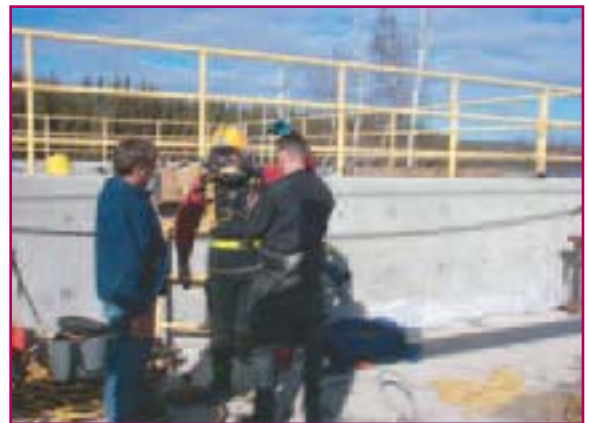
Plongeur se préparant à effectuer une inspection sous-marine du barrage
