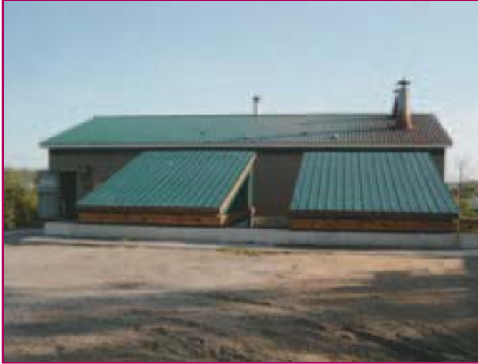
Bâtiment de la chaudière au bois communautaire
