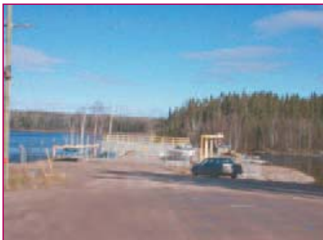
Centrale hydroélectrique sur la rivière Severn
