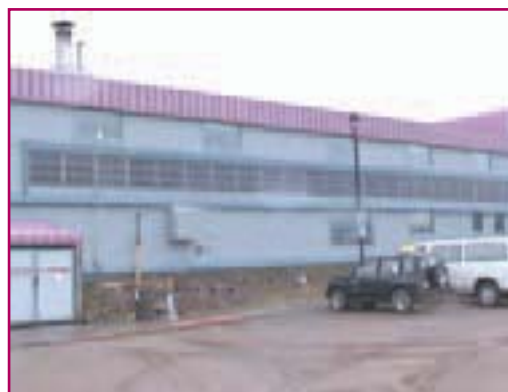
Panneaux solaires installés sur le mur sud du Collège de l'Arctique du Nunavut
