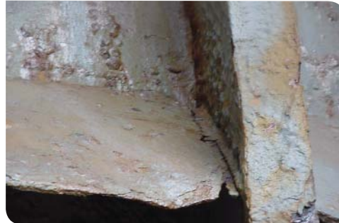
Gousset anti-flambage – membrure de muraille
