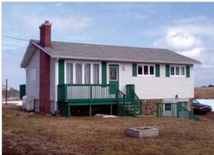
Figure 2 Maison de Pouch Cove. Vue vers le nord depuis le devant de la maison; cheminée sur la façade est. Emprise au sol de 26 x 36 pi. Le support de couverture est composé de planches emboutées pas très étanches à l'air, particulièrement où elles sont en saillie au-dessus des murs de pignon.
