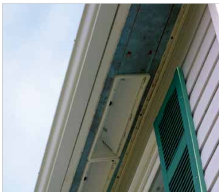
Figure 4 Aérateurs de soffite à clapet en place, en position fermée. Les premiers modèles étaient des « prototypes en vraie grandeur » fabriqués à partir des bacs à fleurs pour fenêtre dotés de clapets « Corroplast ». Ces derniers se sont avérés trop bruyants, malgré la présence de coussinets en caoutchouc mou.
