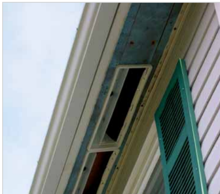
Figure 3 Aérateurs de soffite à clapet en place. Position ouverte
