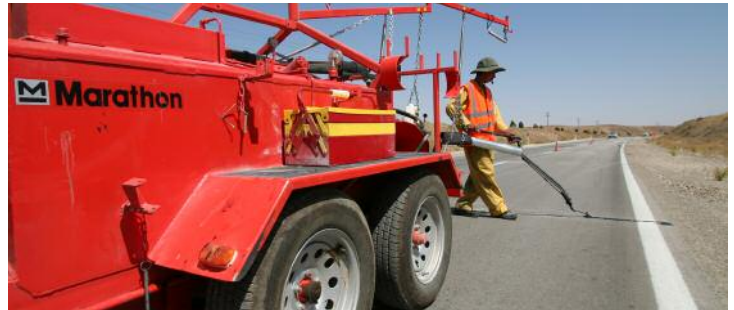
Marathon Equipment, une entreprise de Burlington en Ontario, fait la démonstration de sa machine à colmater l'asphalte fissurée à Shiraz, en Iran.
