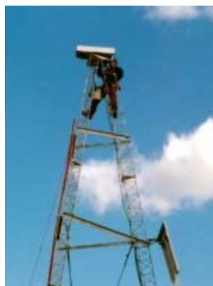
Alignement au laser à Hay River
